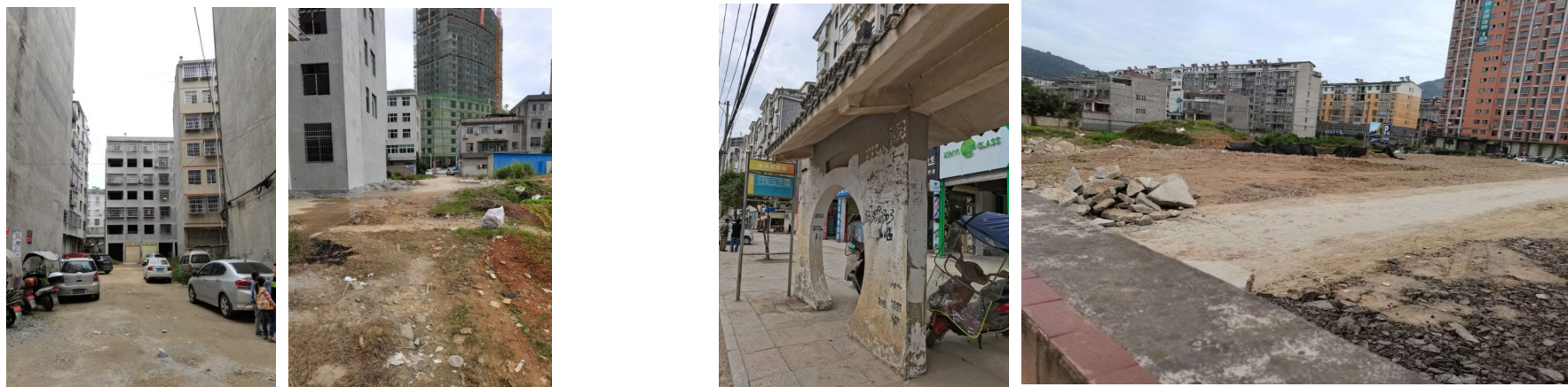
①柏树下村道路未硬化，私家车和废弃车辆随意停放。②特色公交站台以及正在建设的社会停车场。
